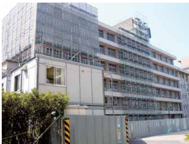
(改修中の法文学部1号館)
